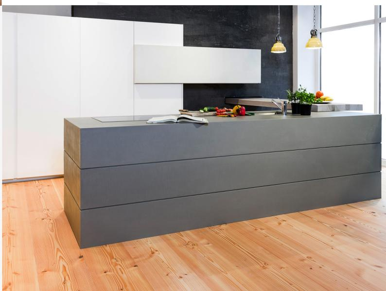
Douglasiendiele im 3-Schicht-Aufbau mit kleiner Fase an der Längsseite und ca. 4 mm Laufschiicht sowie ca. 4 mm Gegenzug aus gleicher Holzart, dazwischen Weichholzmittellage.
